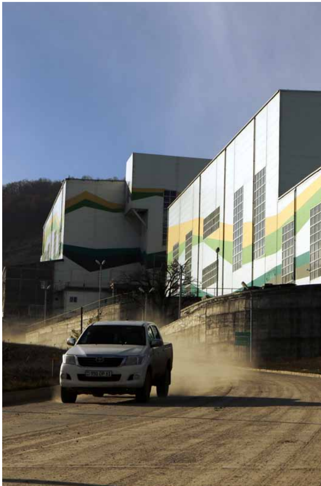
Fabriksbygningerne, som FLSmidth opførte i mineområdet i Teghut. Faciliteterne blev taget i brug i 2014. Pension Danmark har stillet 350 millioner kroner til rådighed for Vallex Group via et lån i en russisk bank. EKF Danmarks Eksportkredit garanterer at pensionskassen får pengene retur.
