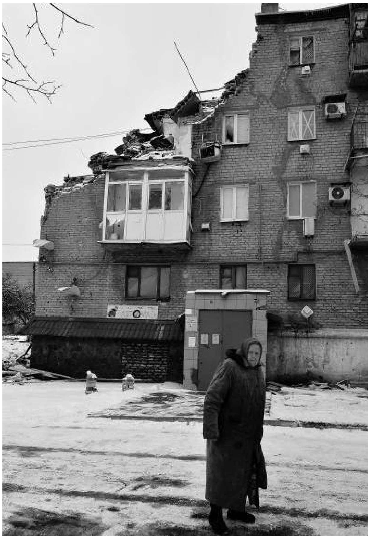
Auch in Dokuschajewsk im Donezker Gebiet ist viel wieder aufzubauen.
