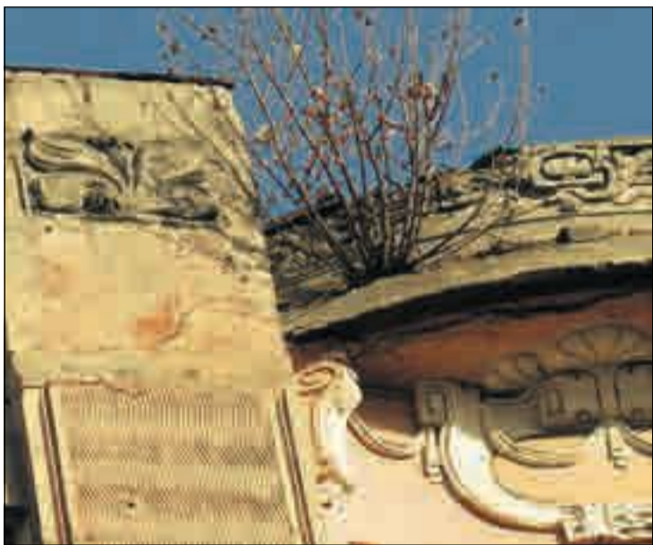
FORFALL: Planter slår rot og skaper enda større sprekker.
