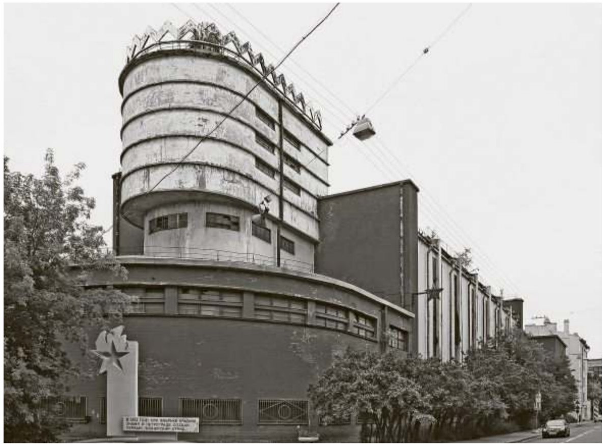
Textilfabrik Rote Fahne nach Plänen von Erich Mendelsohn, gebaut 1926 JENS MALLING
