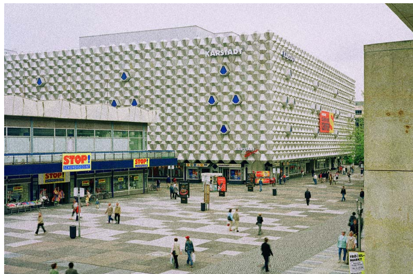
VÆK. Det tidligere DDR-stormagasin 'Centrum' på Prager Straße i Dresden, Tyskland. Revet ned i 2006.
